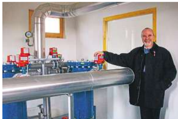
Im berühmten Széchenyi-Heilbad badet man in 77 Grad warmem Thermalwasser aus über 1000 Metern Tiefe. Ingenieur Gábor Szita (links) vor der Anlage eines Förder- bzw. Rückführbrunnens für Thermalwasser Fotos: Qu11
